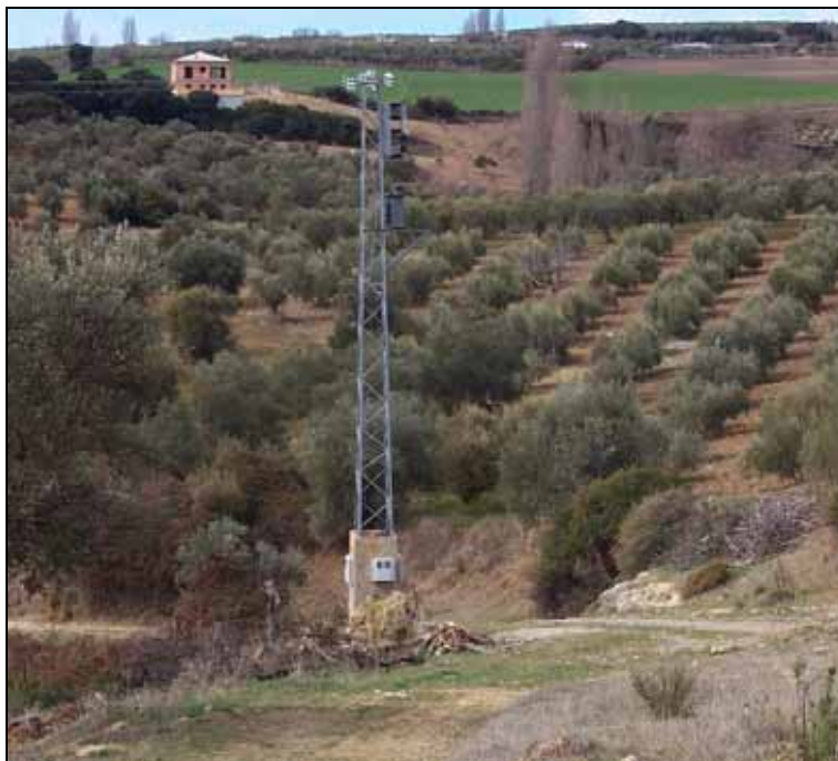
Torre eléctrica de alta tensión, ubicada junto al camino que desciende al río. Margen izquierda.
